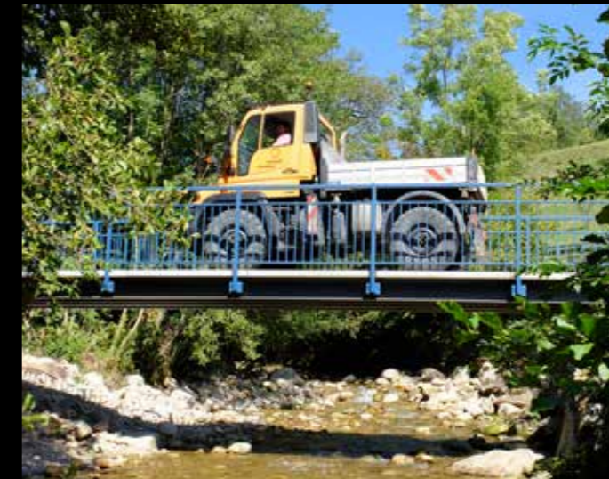
Die Brücke mit Carbonplatte ist zulässig bis zu 16 t.
