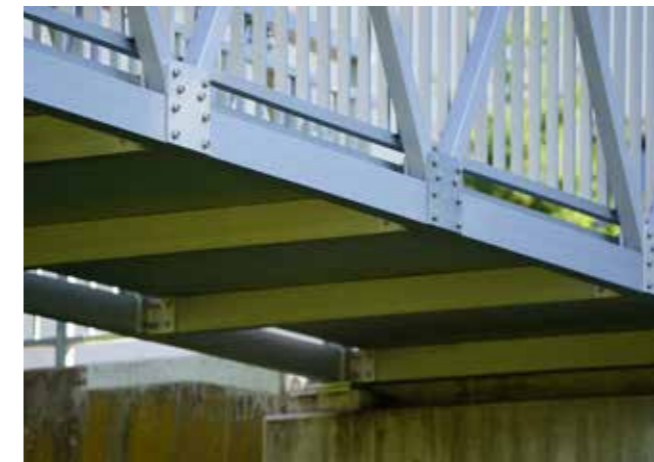
Aluminiumbrücke mit Schraubenverbindungen.
