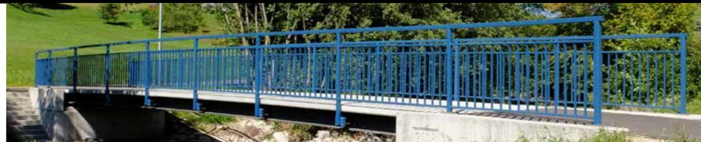
Brücke mit Carbonbetonplatte in Ottenhöfen.
