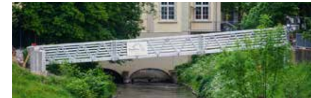
18 m lange Behelfsbrücke aus 3 Modulen in Rastatt.
