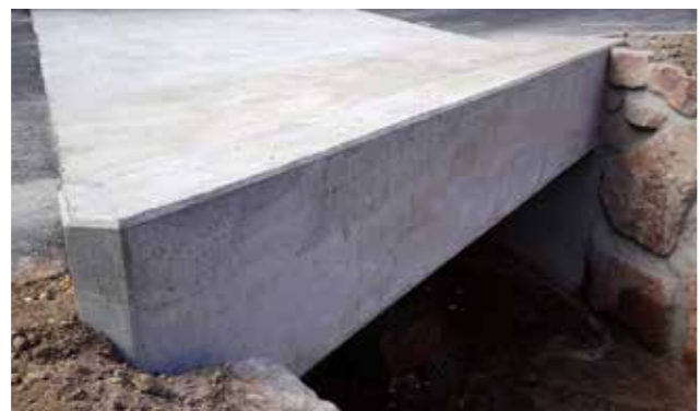
Brücke mit Carbonbetonplatte in Gaggenau.
