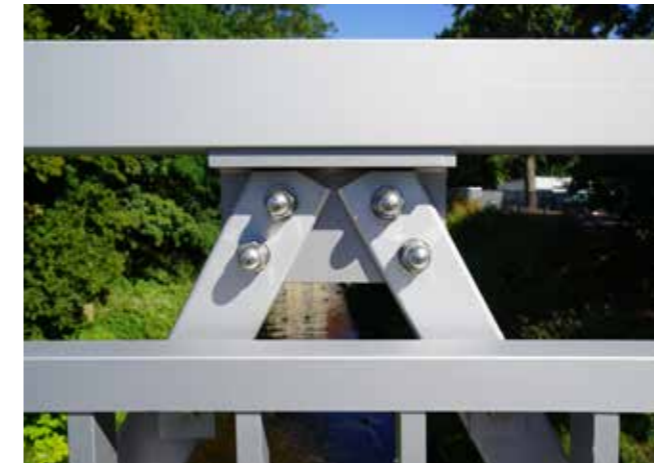
Aluminiumbrücke mit Schraubenverbindungen.
